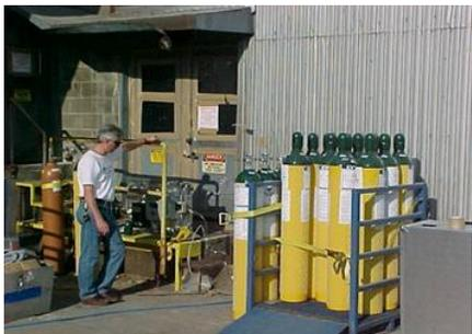
*Иллюстрация 16.2.1: Цилиндрический фосфин ( $PCO_2FUME$ ), используемый для регулирования уровней фосфина на большом мукомольном заводе в Мичигане, США (фотография: Д.Мюллер)*
