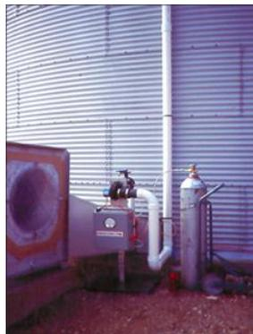
*Иллюстрация 10.3.2: Цилиндрический фосфин, используемый в системе рециркуляции (фотография: Д.Мюллер)*
