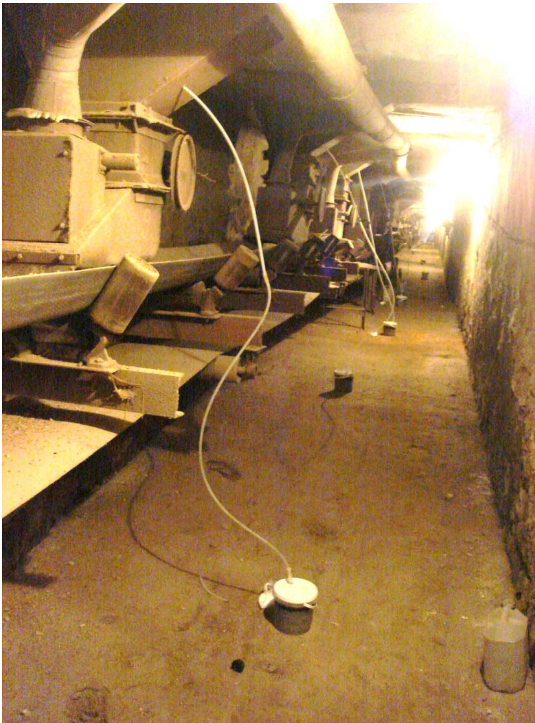
Рис.1 Подсоединение генераторов газа фосфин СГФ-М2 к силосам.
